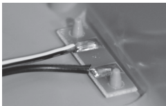
ÜBERFLUTUNGSSCHUTZ Überflutungsschutz zur Erkennung von Lecks.
